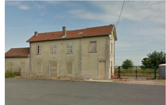
Ancienne gare de Witry lès Reims
