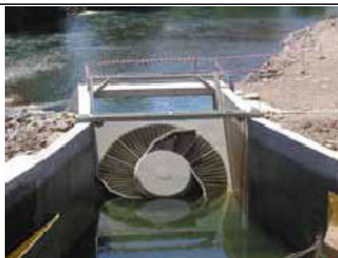
Figure 19 : Photo montrant la turbine en position de travail (site de Millau)
