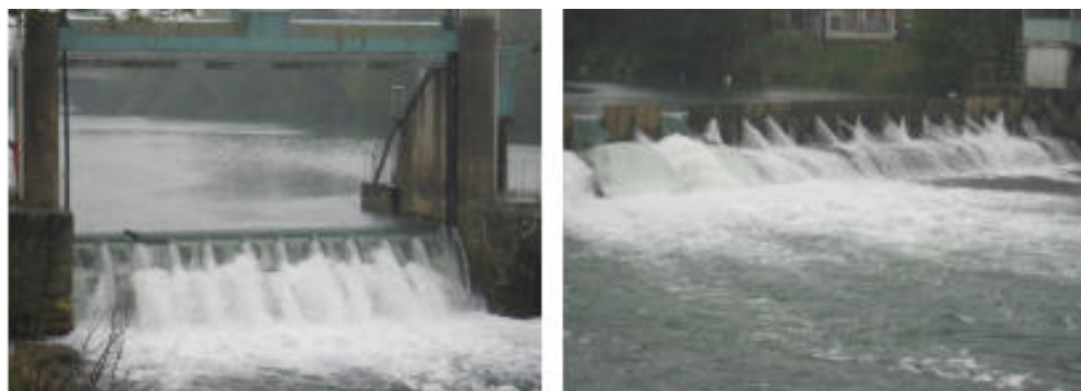
Figure 3 : Vue du barrage de Châlons (pertuis et hausses mobiles)
