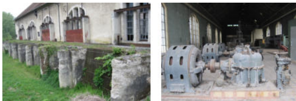
Figure 35 : Centrale hydroélectrique de Condé-sur-Marne
