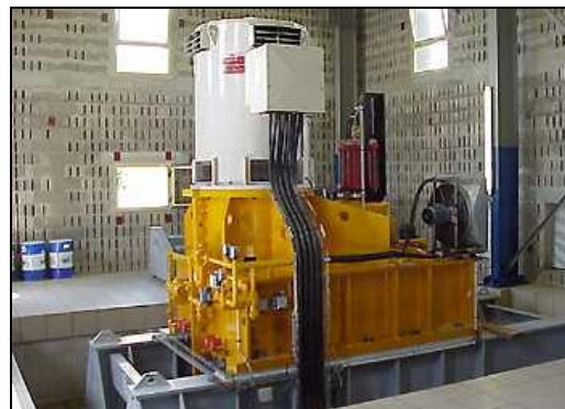
Figure 41 : Multiplicateur et génératrice
