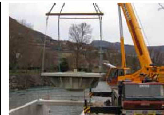
Figure 18 : Photo montrant la pose de la turbine par grue (site de Millau) 5
