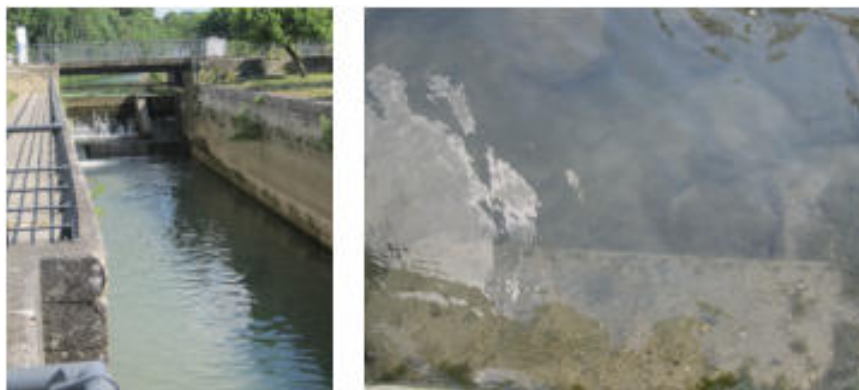
Figure 16 : Photos montrant le radier sas de l'écluse
