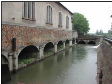
Canal de fuite de l'usine
